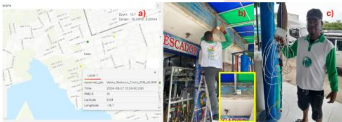
Ilustración 2 Evidencias Red COCO - Instalación sensores
